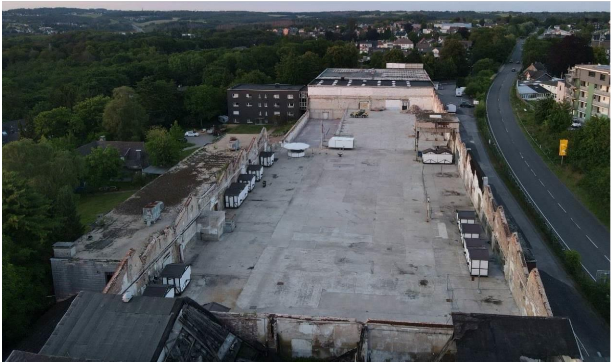
Bild 1: Blick von Westen nach Osten auf den Gebäudebestand des Rhombus Areals im zentralen Teil des Plangebietes mit den hier oberirdisch nur noch erhaltenen Außenfassaden aus Backsteinen. Am rechten Bildrand der Verlauf der B 51 (Dellmannstraße).
