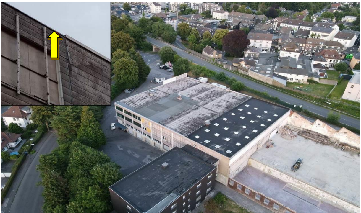
Bild 2: Blick auf den Gebäudebestand im östlichen Teil des Plangebietes mit dem hier noch teilweise in gewerblicher Nutzung befindlichen neueren Gebäudeteil. Am oberen Rand der Verlauf der B 51 (Dellmannstraße). Verkleinerter Bildausschnitt oben links: Oberer Fassadenabschluss mit Fledermausquartier (Zwergfledermaus).
