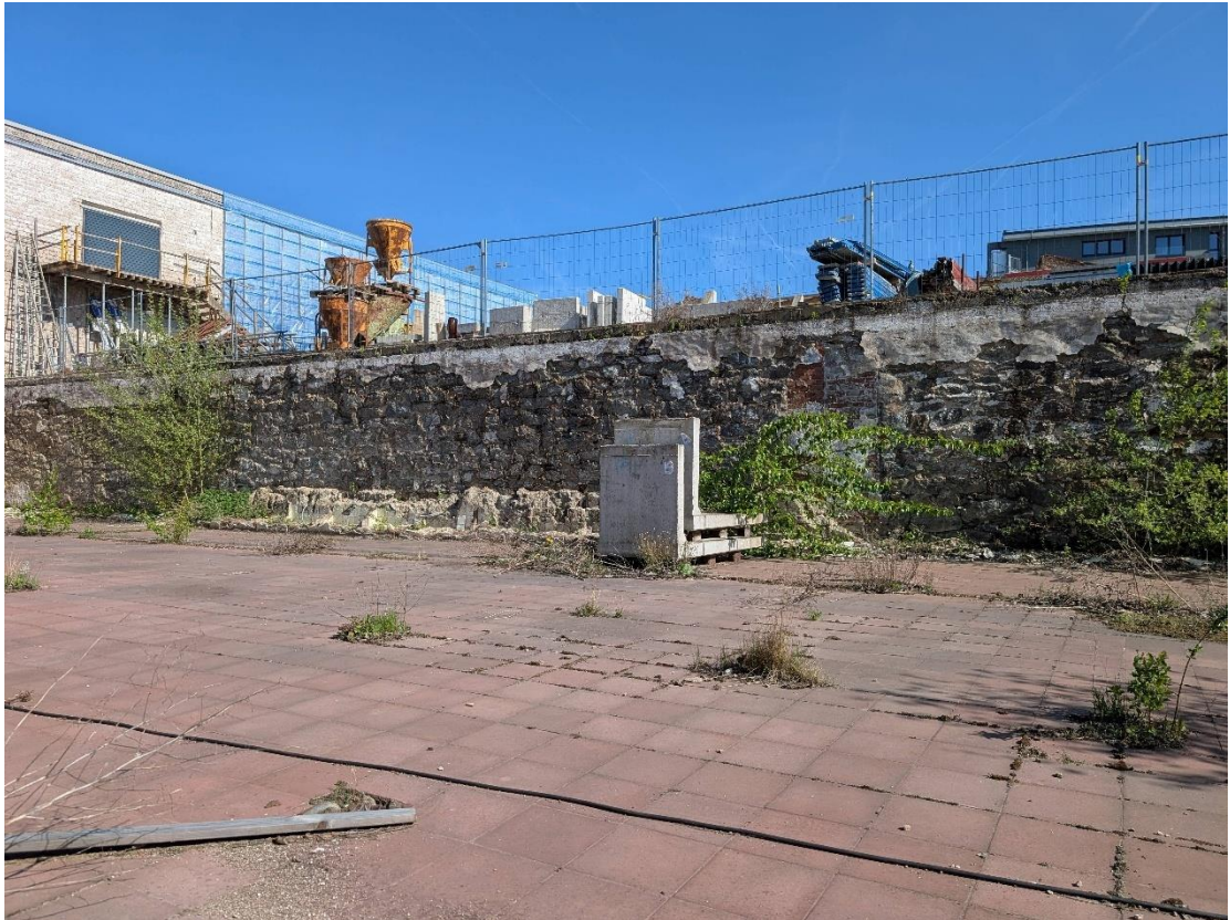
Bild 5: Teilflächen der desolaten Gebäude werden als Lager genutzt.
