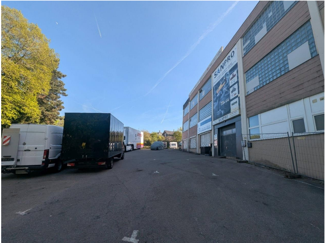
Bild 3: Nordosten; intakte Gewerbehallenteile und Parkplatz, links: Baumhecke entlang der Remscheider Straße
