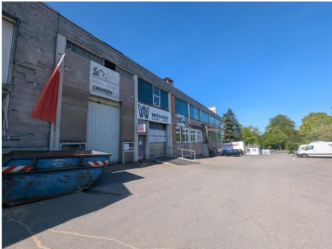
Bild 1: Südliche Plangebiet; hier noch genutzte und intakte Gewerbehallenteile
