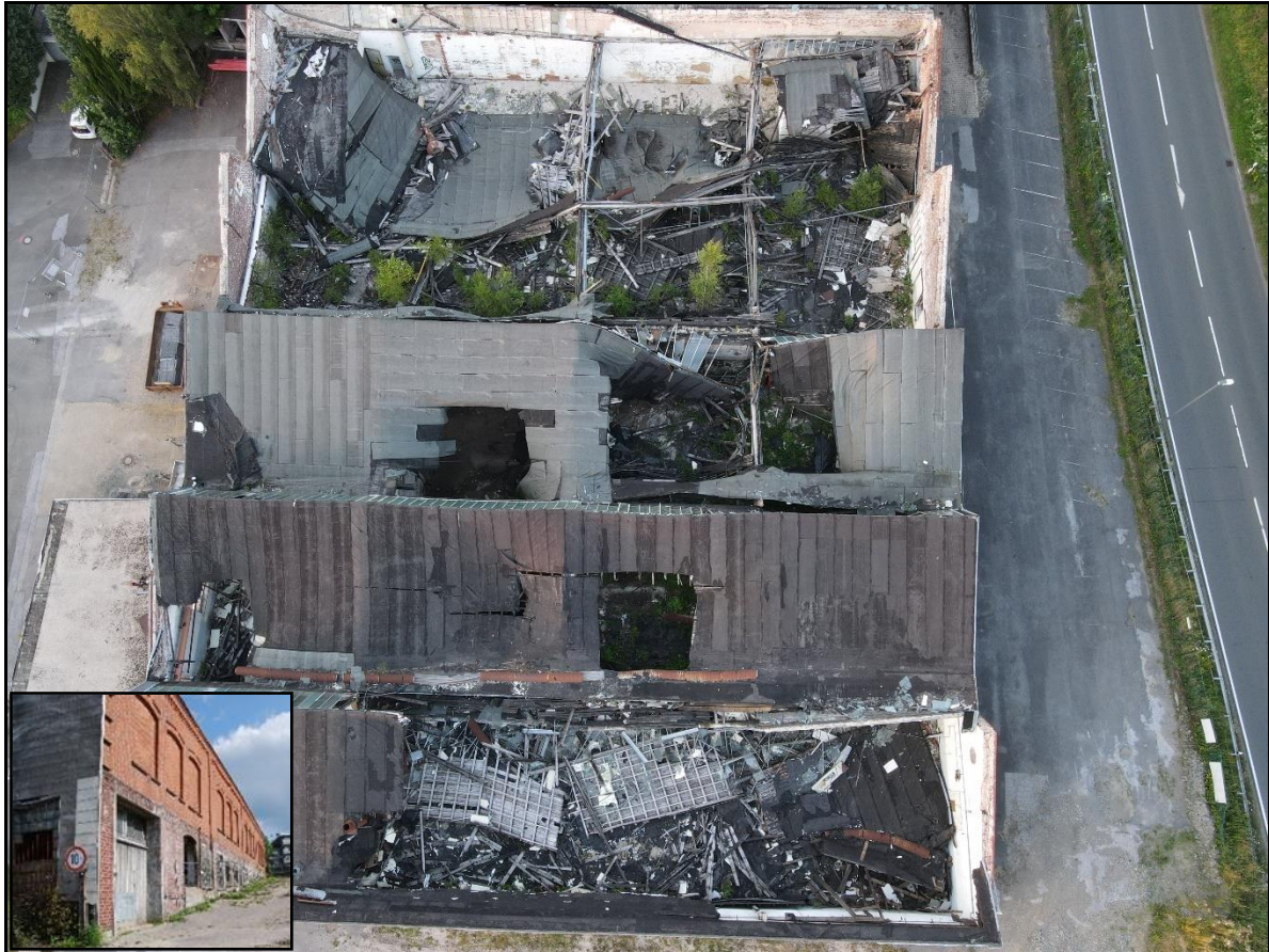
Abb. 7: Überwiegend eingestürzte Dachkonstruktionen im westlichen Teil des Gebäudebestands sowie spaltenreiche Backsteinfassade.
