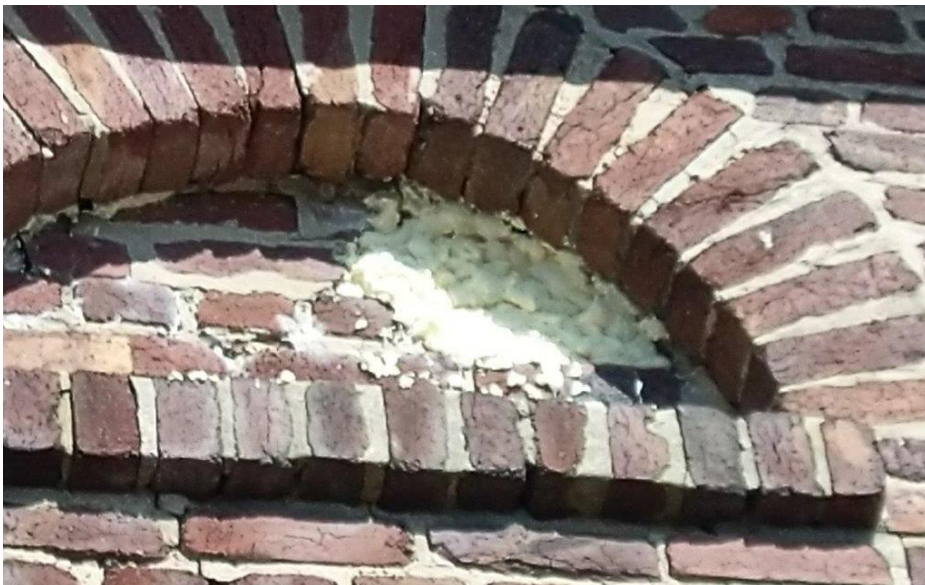
Verschlossene Nische an der Westfassade.
