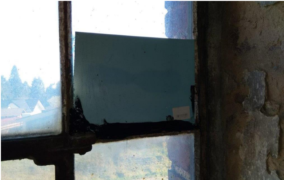
Verschließung eines beschädigten Fensters an der Südfassade.
