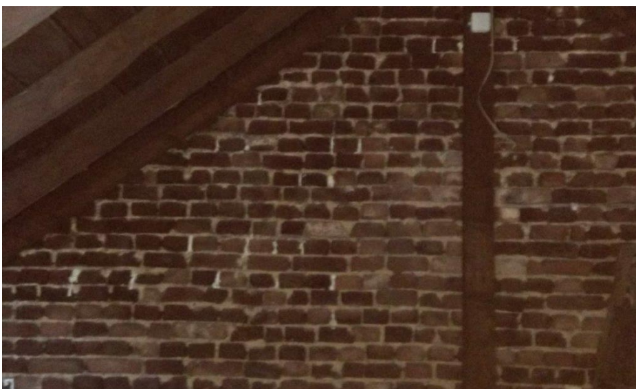
Die Spaltöffnungen im Dachgeschoss wurden verschlossen.
