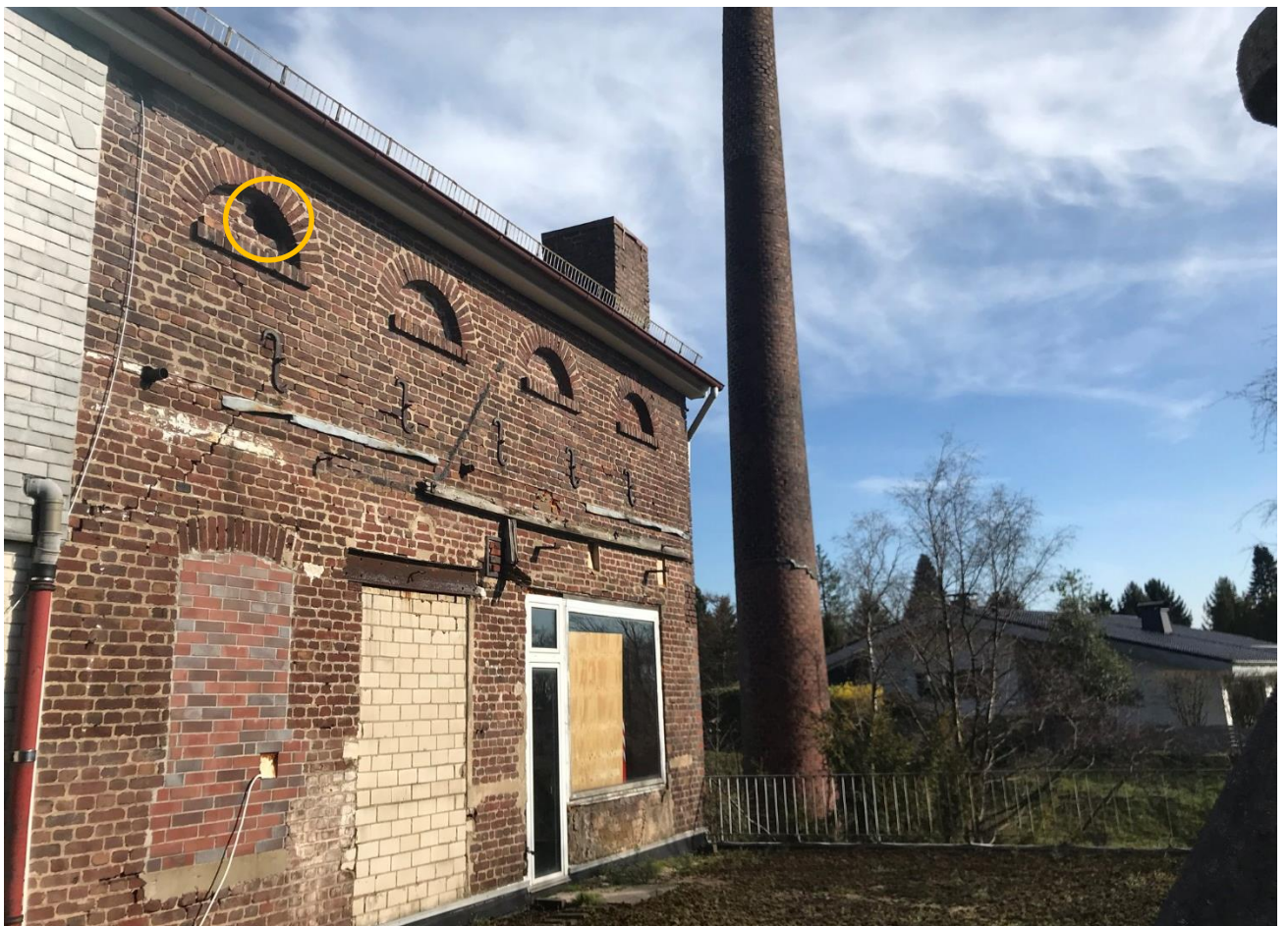
Foto 4 Blick auf die südwestliche Gebäudefassade mit Nische (oben links).
