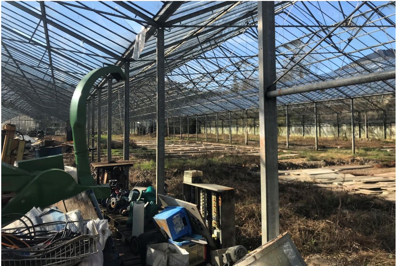
Foto 1 Blick in den nordwestlichen Bereich des Gewächshauses.
