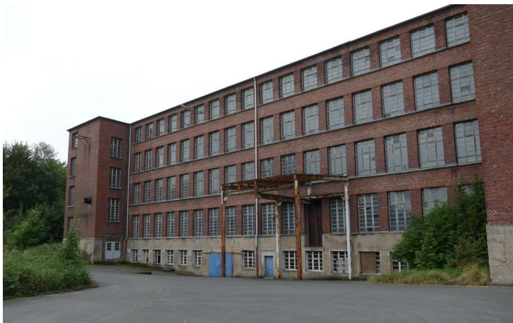
Standortalternative: ehemalige Schuhfabrik Neuenhaus
